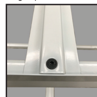
Fixation de la traverse de renfort
